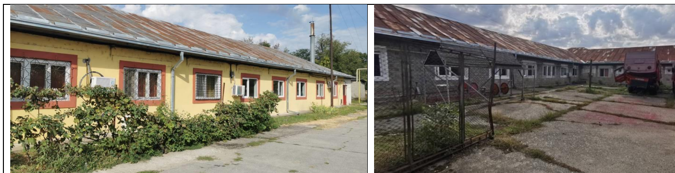
Figura 6 Clădirea administrativă C1 a DPB
